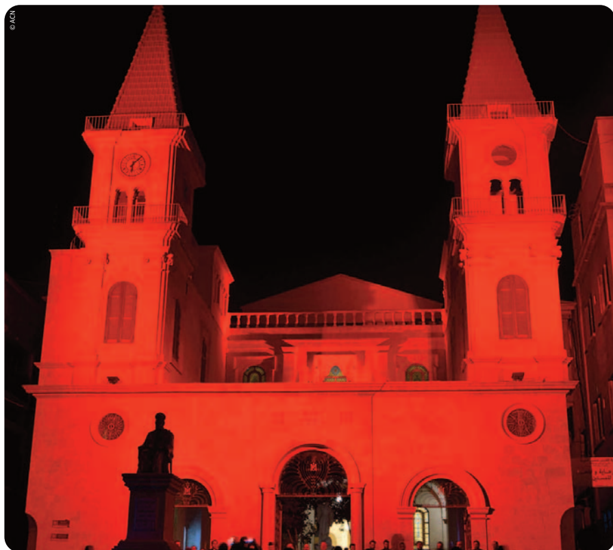
RED WEDNESDAY weltweit: Die maronitisch-katholische Kathedrale St. Elias in Aleppo/Syrien. KIRCHE IN NOT hat den Wiederaufbau des im Krieg zerstörten Gotteshauses unterstützt.
